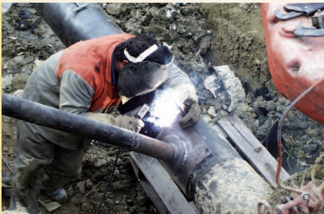
Naváranie obtokového potrubia trasového uzáveru pri obci Jamník
