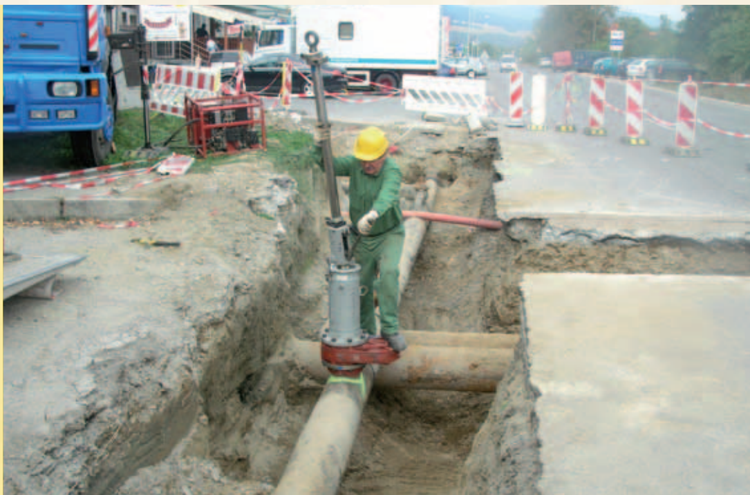
Uzatváranie potrubia na strednotlakovom plynovode v rámci rekonštrukčných prác
