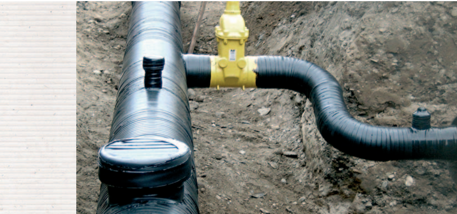
Zrekonštruovaný plynovod pred dokončením povrchovej úpravy
