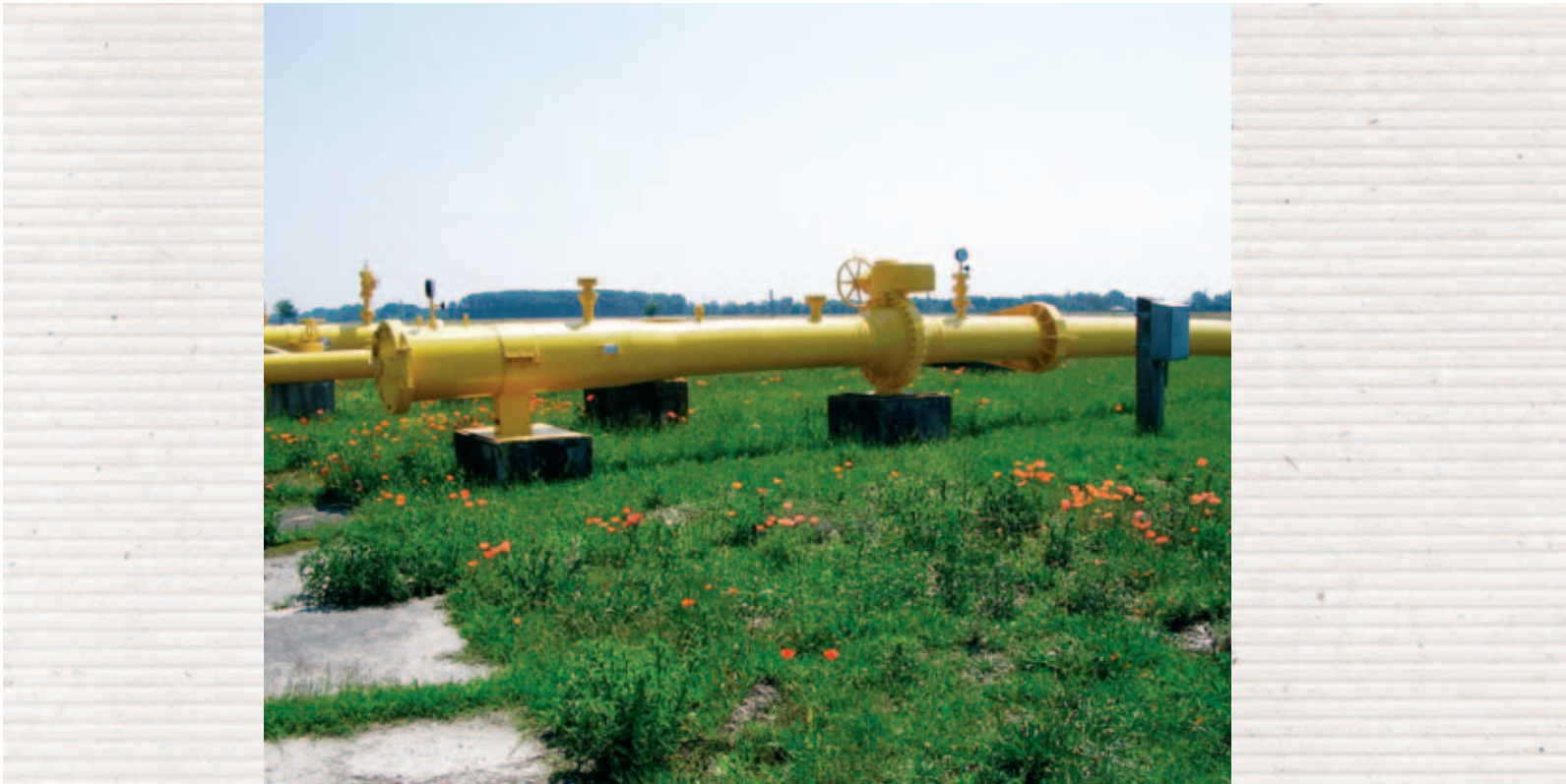
Vstupná komora na vkladanie čistiaceho a monitorovacieho zariadenia, tzv. ježka, do vysokotlakového plynovodu
