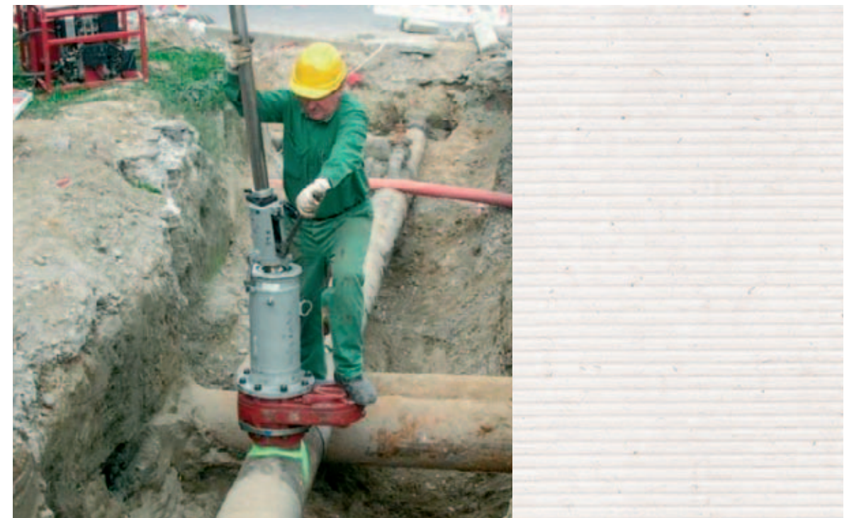
Uzatváranie potrubia na strednotlakovom plynovode v rámci rekonštrukčných prác
