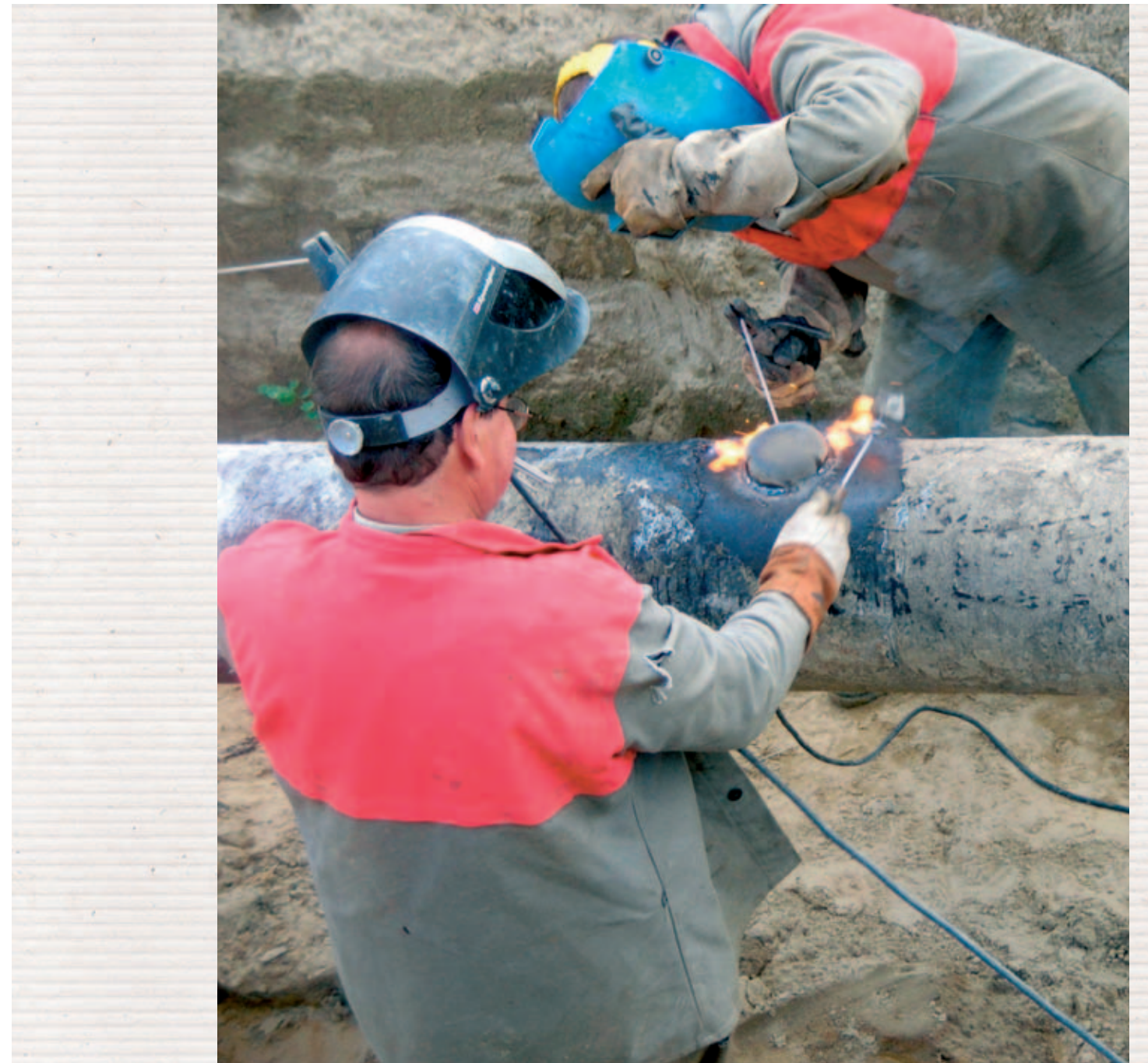
Zváranie na vysokotlakovom plynovode v rámci rekonštrukčných prác
